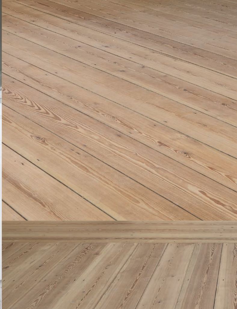
Eksisterende gulve efter slibning og sæbebehandling.
