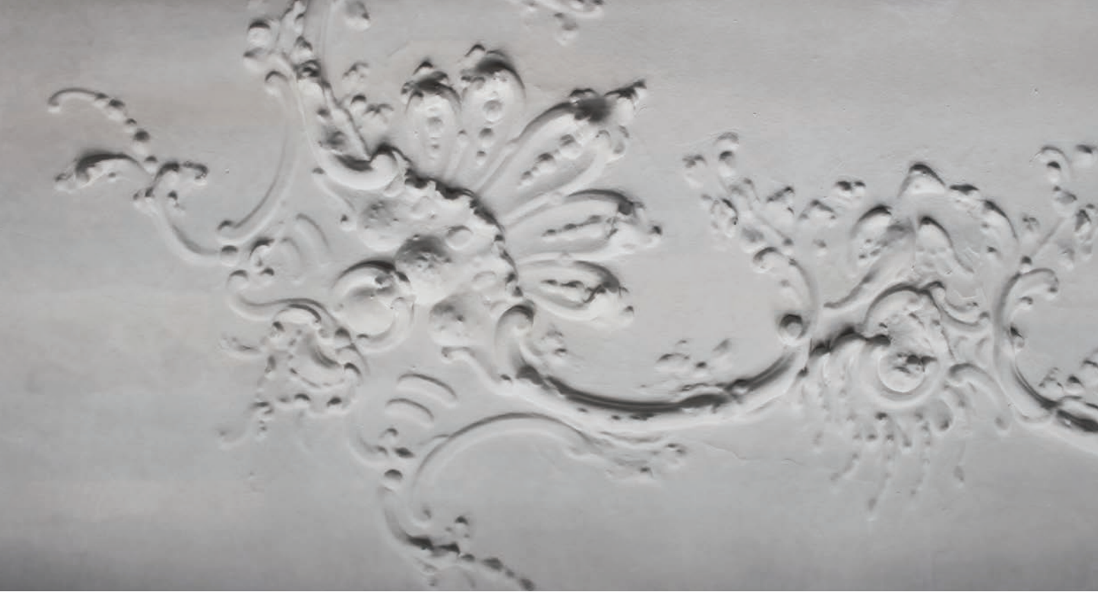
Stuklofter og gesims på Amaliegade 23- 25. Findes primært i palæbygningerne ud mod Amaliegade.
