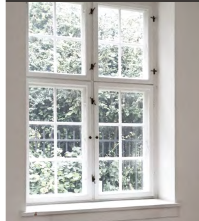
De smukke palævinduer eftergås for tætning og udlusning.
